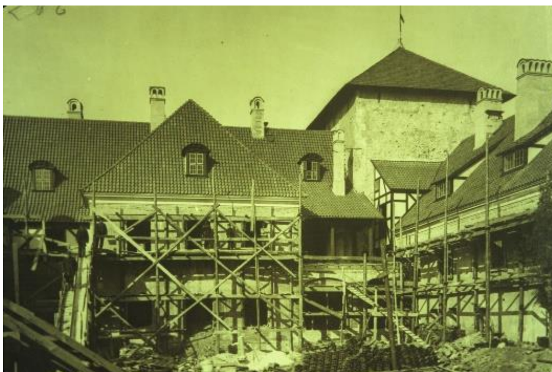
18. Attēls. 1907. gadā būvdarbu laikā. Redzami pils atjaunošanas būvdarbi brīdī, kad pabeigti jumti un dūmeņi. Tornim uzlikts pagaidu četrslīpju jumts ar skaidu segumu un vējrādītāju. Avots: NKMP PDC arhīvs. Fotografijas oriģināls - Klausa fon Rozena arhīvā.
